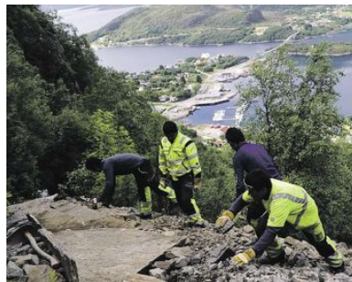
FLOTT UTSIKT: Sherpaene fra Nepal er allerede en måned foran skjema siden de har god tilgang av gunstige steinheller i fjellet ovenfor Midsund sentrum. Det er også fløyet inn stein med helikopter.
