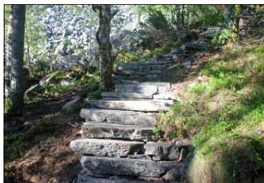
Tungt: Steinheller tilpasser terrenget og legges opp i Midsundura.
